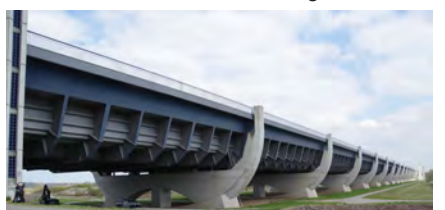
Wasserstrassenkreuz Magdeburg: Trogbrücke
